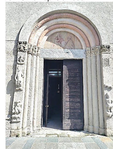
Il portale romanico della chiesa di San Colombano
