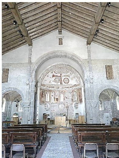
Interno della Chiesa di San Colombano
