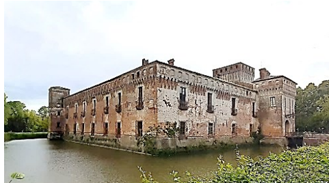
Il maniero di Padernello con il fossato
